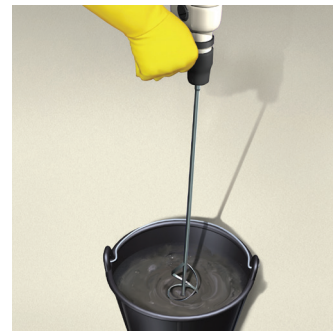
Trộn cho đến khi hỗn hợp đồng nhất, nhuyễn, không vón cục (sau khi trộn nhuyễn, ngưng lại vài phút rồi trộn lại trước khi thi công)
