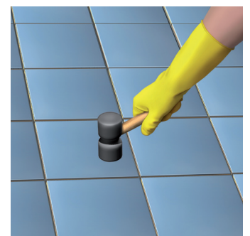
Dùng tay hoặc búa cao su để ấn nhẹ, điều chỉnh viên gạch vào vị trí và đảm bảo vữa phủ đều lên bề mặt viên gạch
