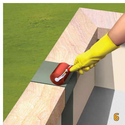
Dùng rulo cao su lăn ép chặt Multiseal vào bề mặt cần thi công.
