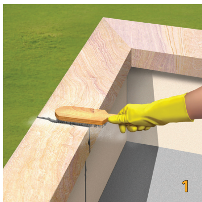
Vệ sinh sạch sẽ bề mặt.
