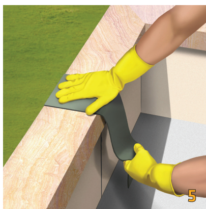
Dán Multiseal lên bề mặt thi công.
