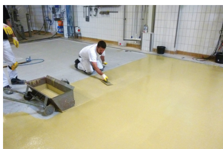
CHIỀU THỨ BẢY: Thi công lớp vữa sàn Sika® Ucrete® UL đóng rắn nhanh.
