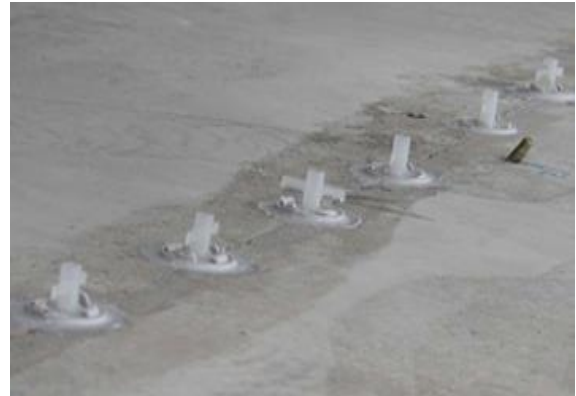
Trám các vết nứt bằng Sikadur®-731 và gắn các bát nhựa lên trên vết nứt
